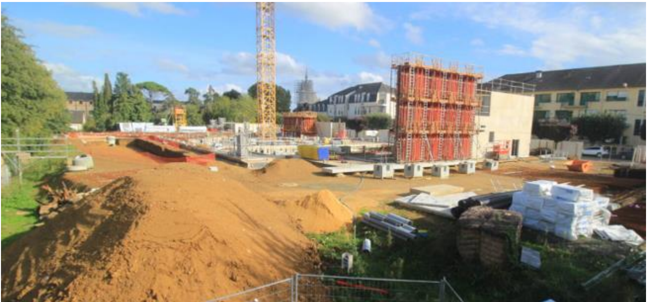
Poursuite des travaux du centre aquatique (septembre 2023)
