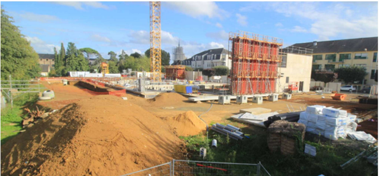
Poursuite des travaux du centre aquatique (septembre 2023)
