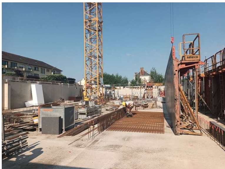
Construction du centre aquatique Poursuite des travaux tout au long de l'année 2023 (photo prise en juin 2023)
